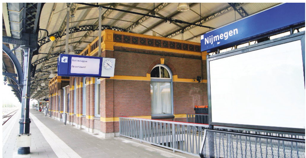
Figuur 13-7. Monumentale wachthuisjes op perron 3-4 van station Nijmegen
