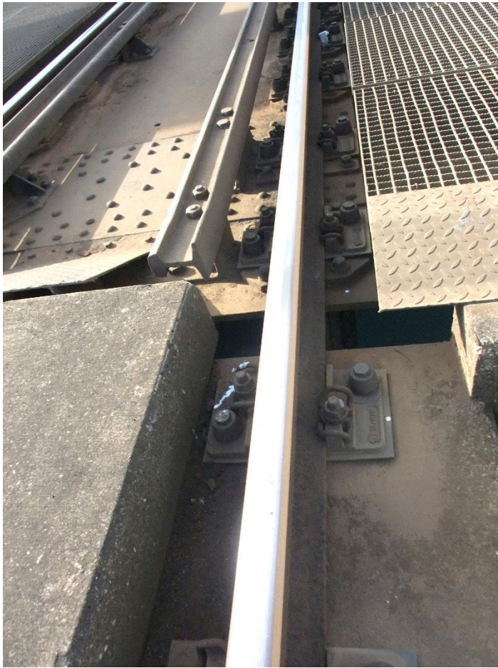
Figuur 9: Foto spoorconstructie van 2019 bij overgang aanbrug naar stalen hoofdoverspanning.
