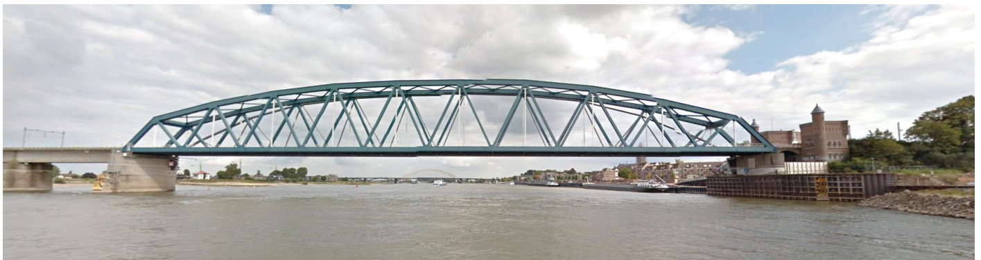
Figuur 4: Aanzicht spoorbrug vanaf de Waal (westzijde).
