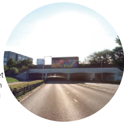
huidige situatie voetgangersverbinding en ontluchtingskoker boven Tunnelweg
