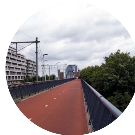
snelfietsbrug naar de Waal
