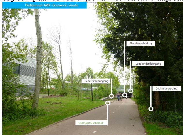
Figuur B3.1: bestaande situatie fietstunnel A28 aan de Uithofzijde
