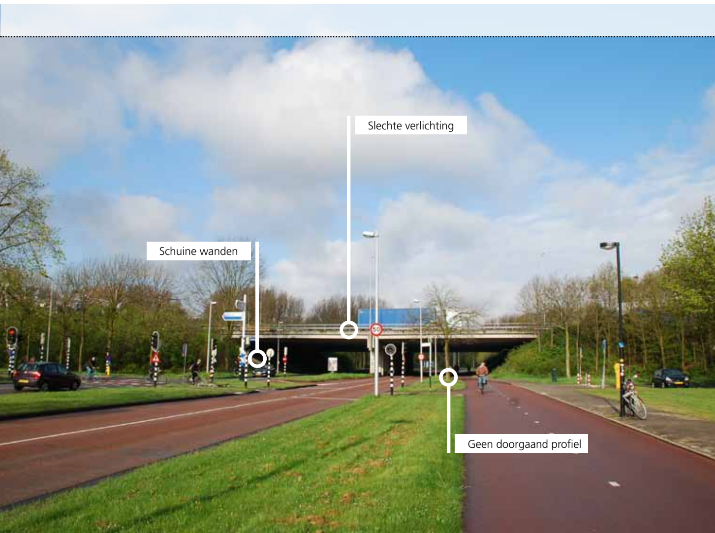
Afbeelding 9.2 Bestaande situatie Leuvenlaan gezien vanaf de Uithofzijde.
