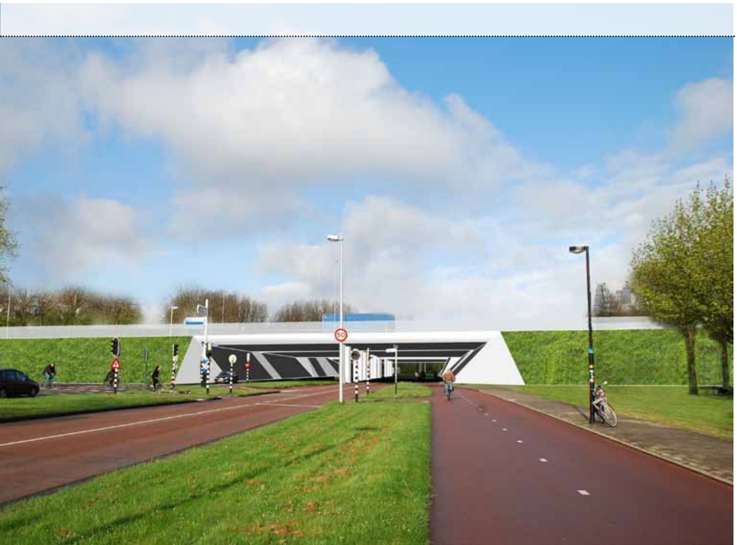
Afbeelding 8.4 Viaduct A27 bij Variant C, gezien vanaf de Leuvenlaan.
