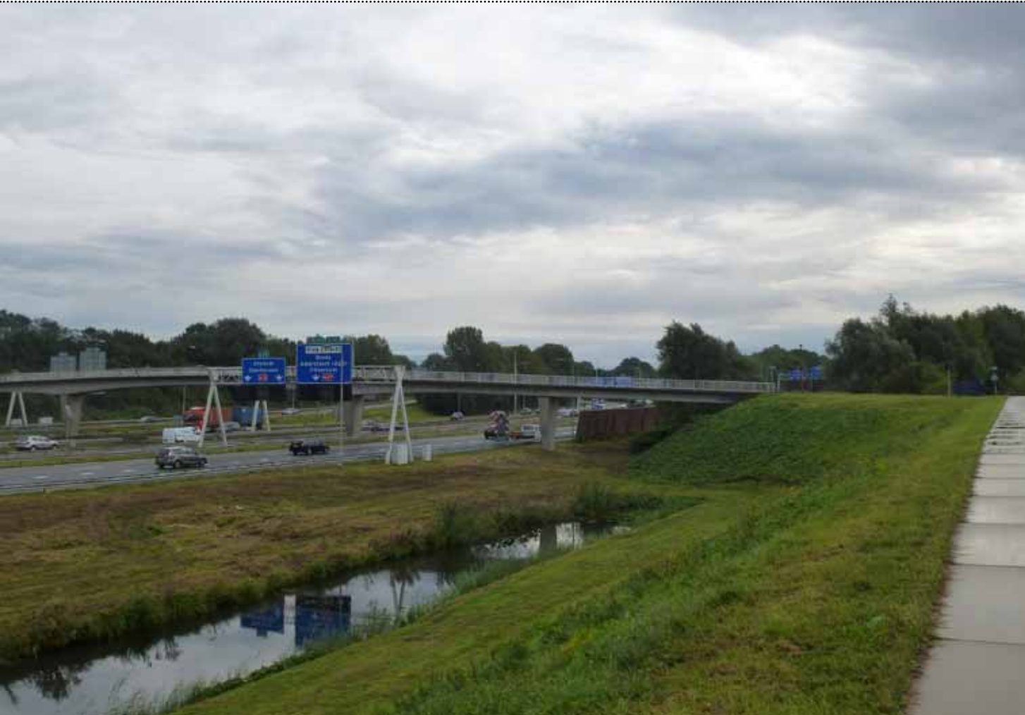
Afbeelding 13.2 Bestaande situatie fietsbrug over de A12, gezien vanaf het zuiden richting knooppunt Lunetten.
