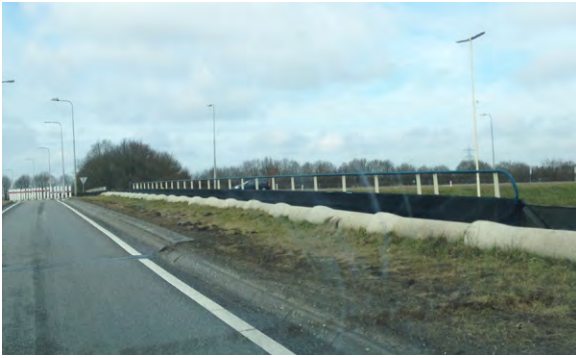
Afbeelding 8.2 Bestaande faunapassage op het viaduct
