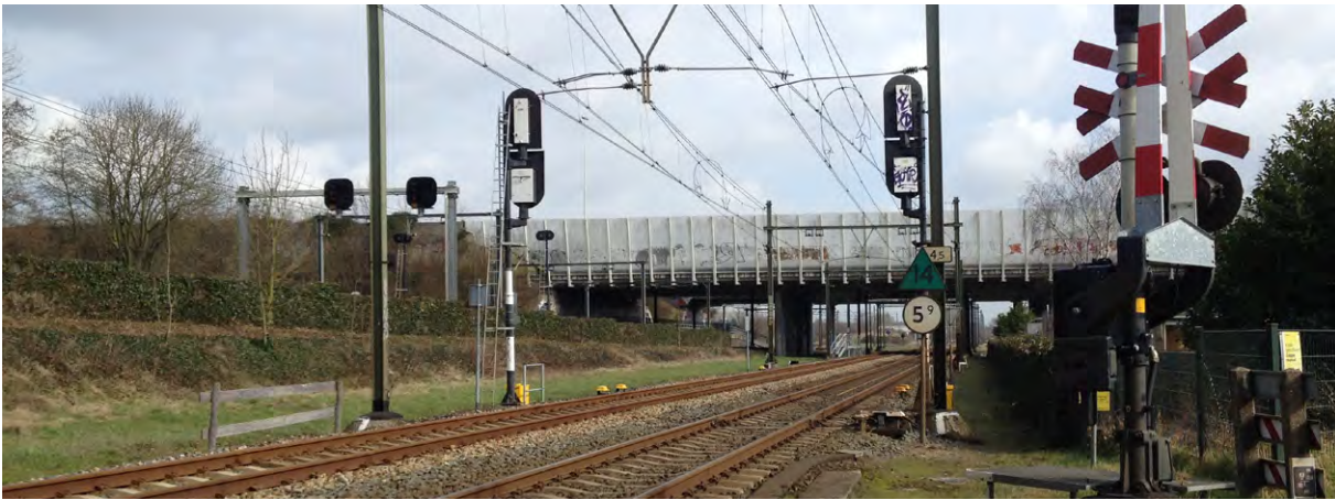
Afbeelding 8.11 Viaduct gezien uit het zuiden
