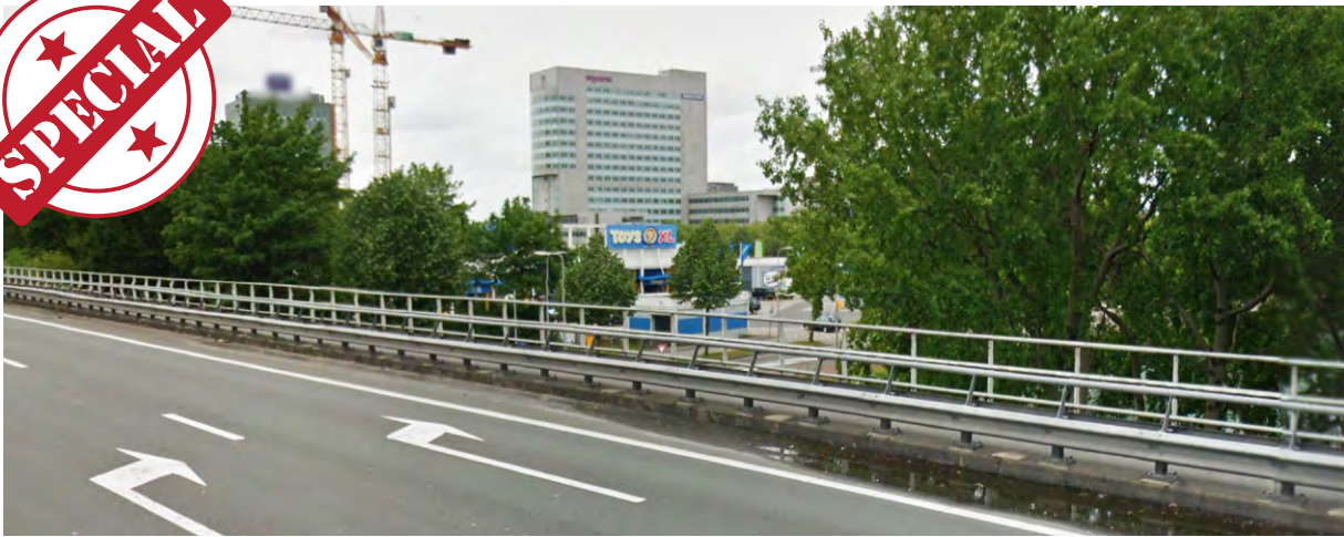
Afbeelding 8.76 De bestaande voetgangersoversteek op het kunstwerk de Vierlingbrug
