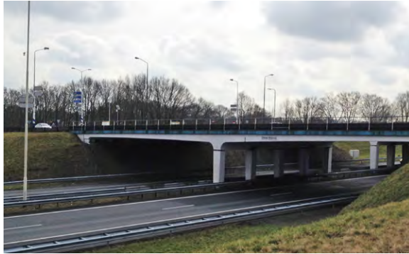
Afbeelding 8.3 Viaduct gezien uit het zuiden
