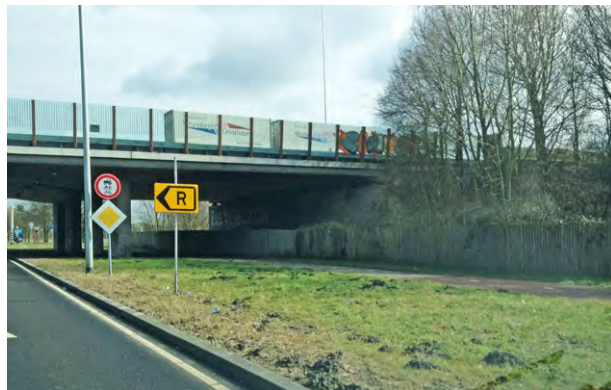
Afbeelding 8.20 De houten afscherming van de faunapassage
