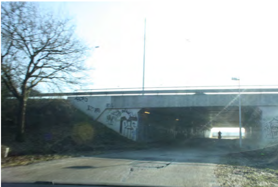
Afbeelding 8.85 Gezien vanuit het noorden
