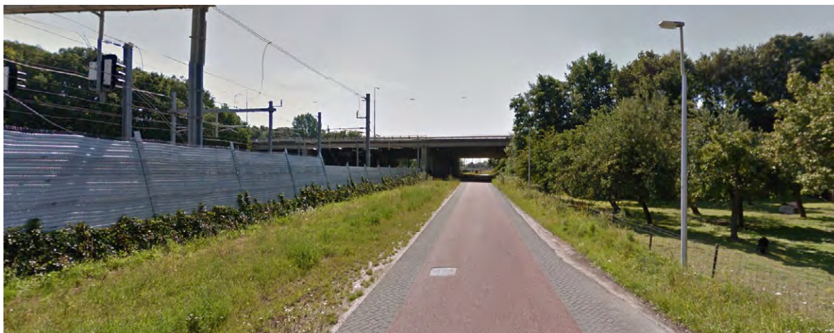
Afbeelding 8.87 Gezien vanuit het noorden
