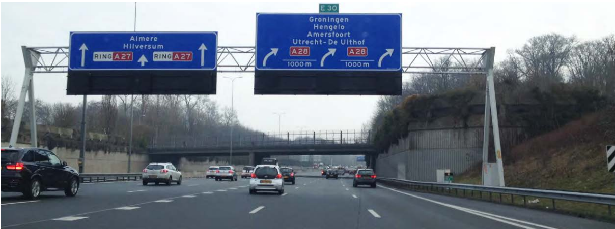
Afbeelding 8.49 Bestaande situatie viaduct
