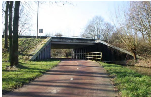
Afbeelding 8.61 westelijke viaduct (Waijensdijk I)
