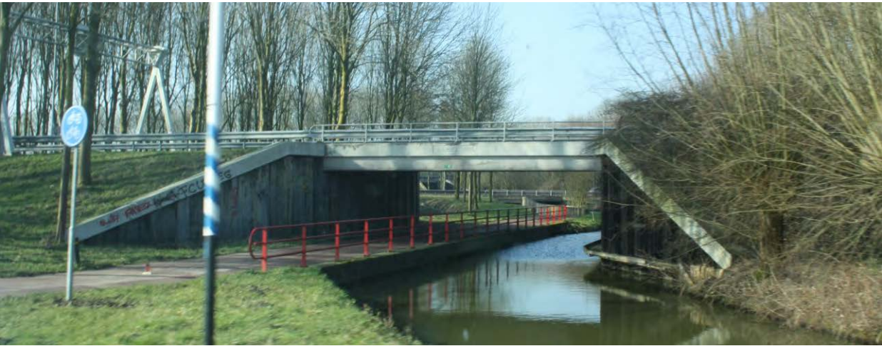
Afbeelding 8.59 oostelijke viaduct (Waijensdijk III)
