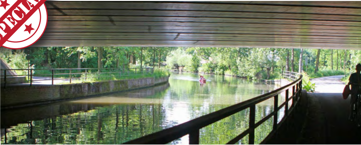
Afbeelding 8.41 Onderdoorgang bestaande situatie
