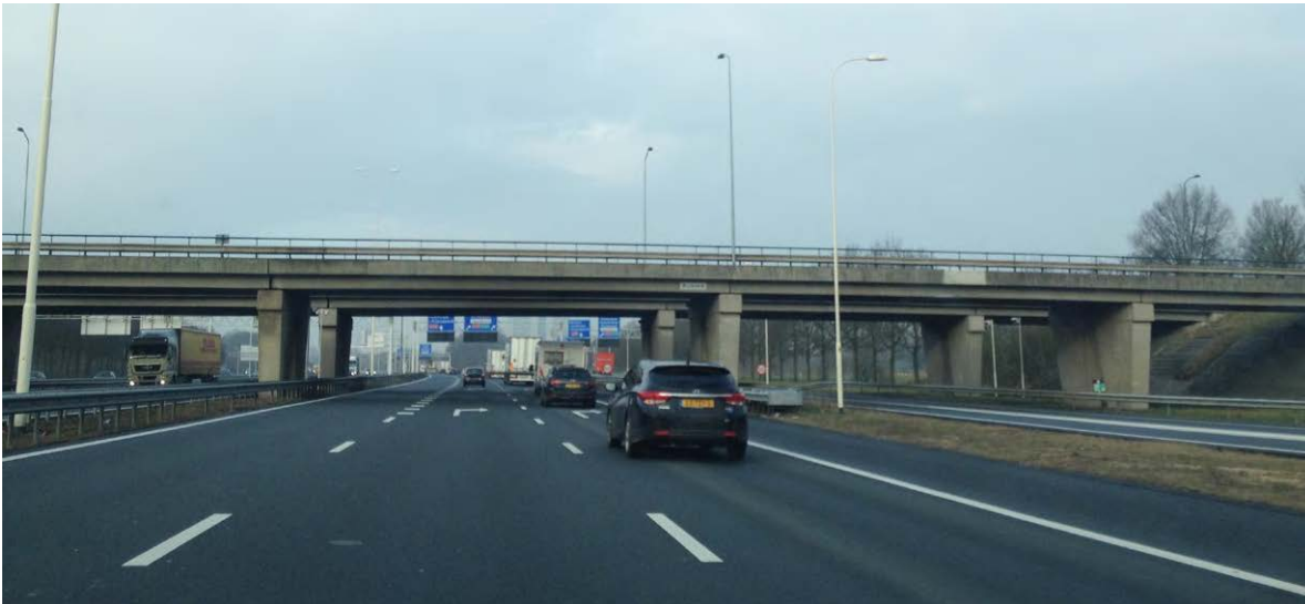
Afbeelding 8.27 Het bestaande viaduct
