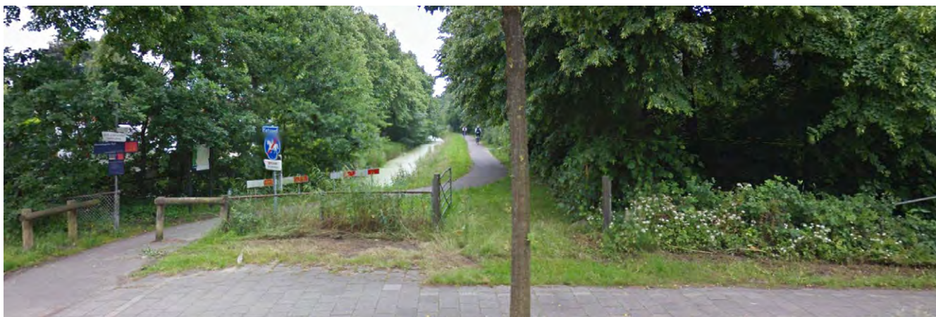
Afbeelding 8.9 Bestaande begin van het fietspad bij de Groenekanseweg
