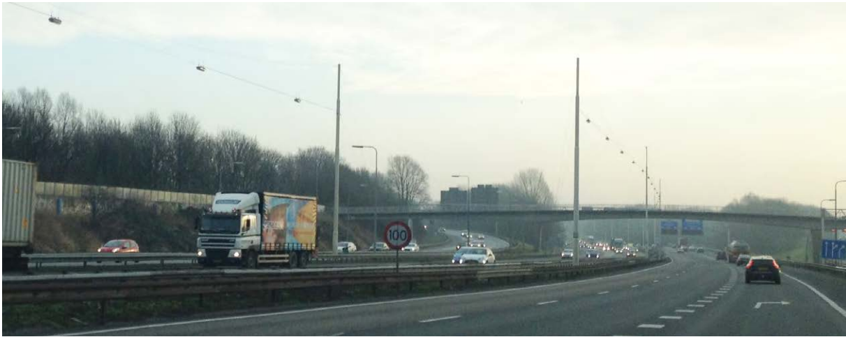
Afbeelding 8.65 De koppelbrug gezien vanaf de A12
