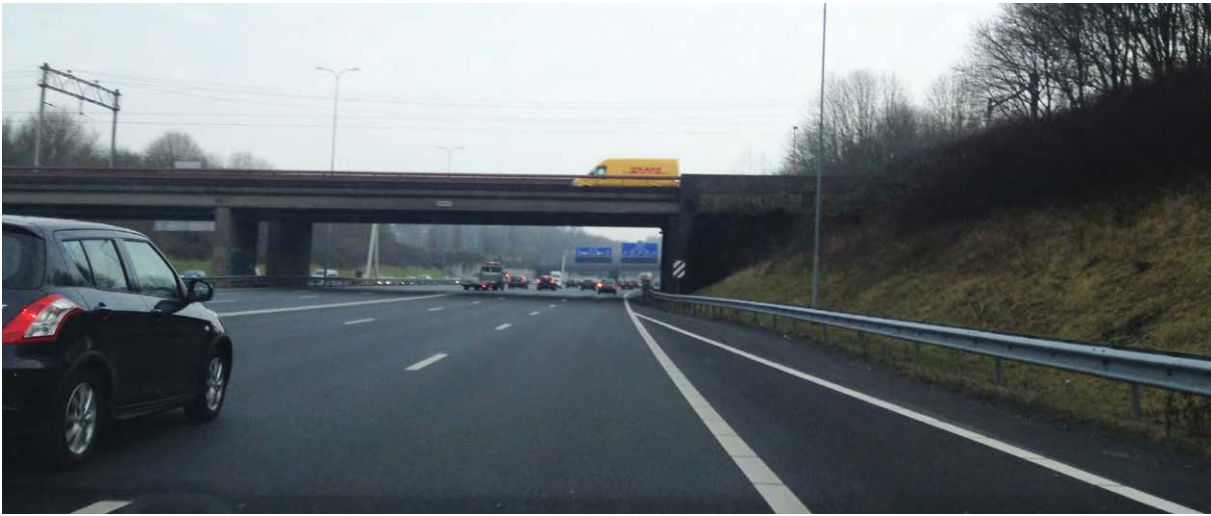
Afbeelding 8.56 Bestaande situatie gezien vanuit het zuiden
