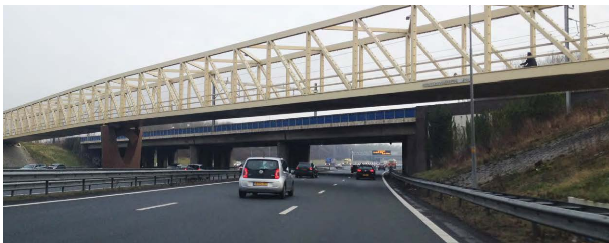
Afbeelding 8.57 Bestaande situatie gezien vanuit het zuiden
