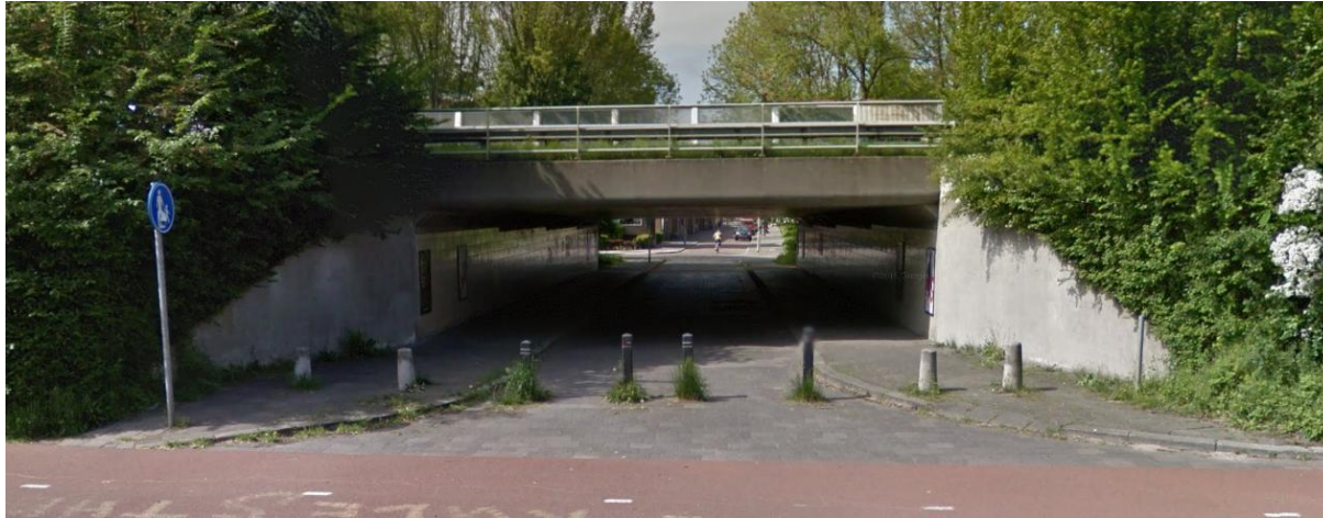
Figuur 1: Huidige fietstunnel Papiermolenlaan (Bron:Google Street View)
