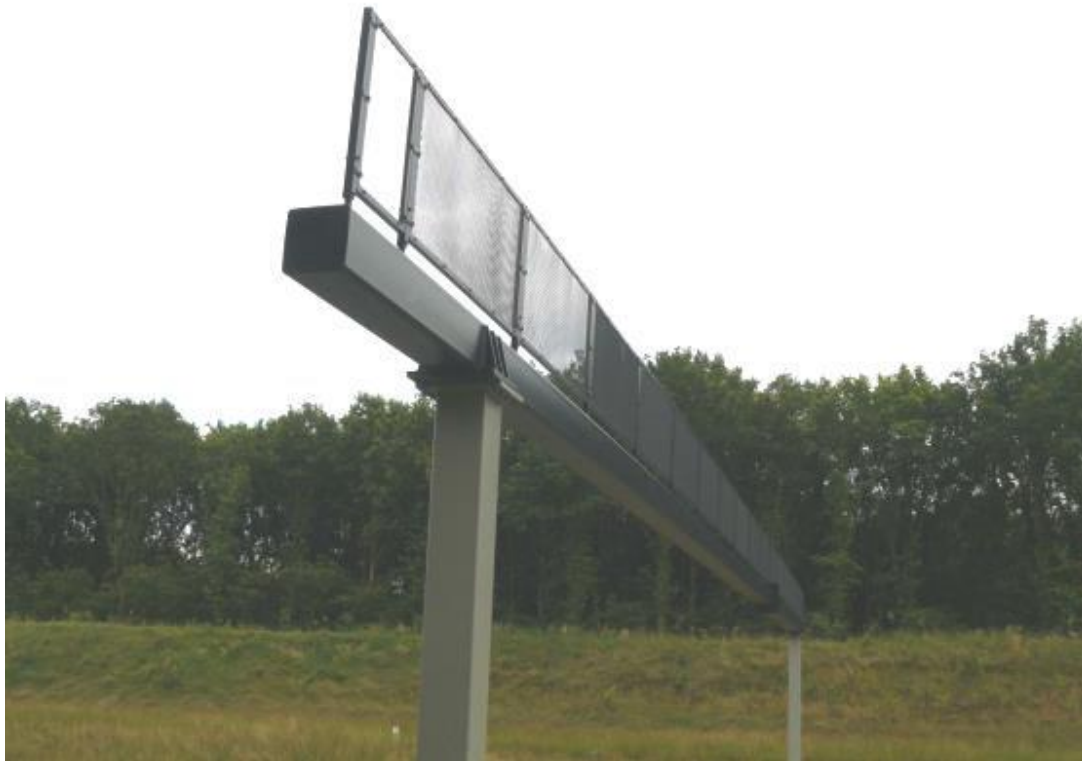
Figuur 12: Speciaal voor vleermuizen aangelegd portaal
