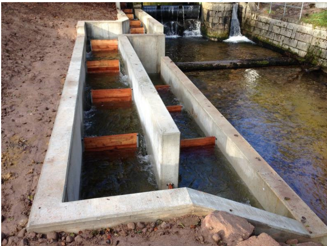
Figuur 3.6. Vertical slot vispassage bij een stuw ( http://www.eppler.de/ ).
