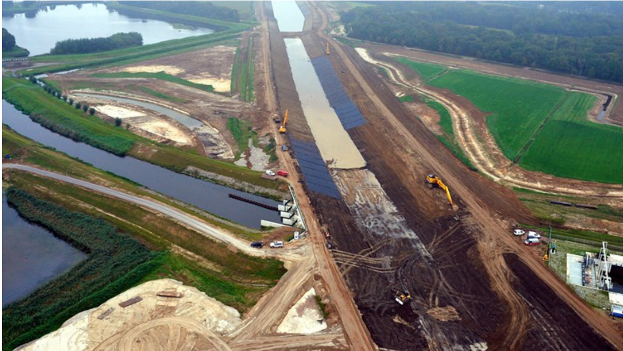
Figuur 13 – Bouw van het Maximakanaal
