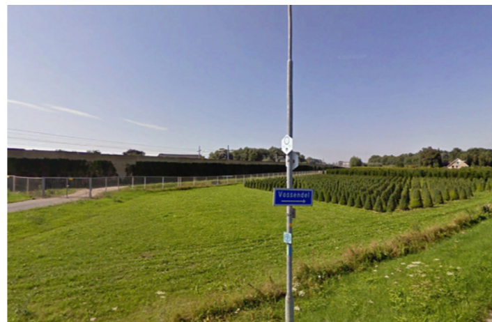
Zicht op de Betuweroute in de bestaande situatie - beeld vanaf de hoek Kandiastraat - Den Oldenhoek
