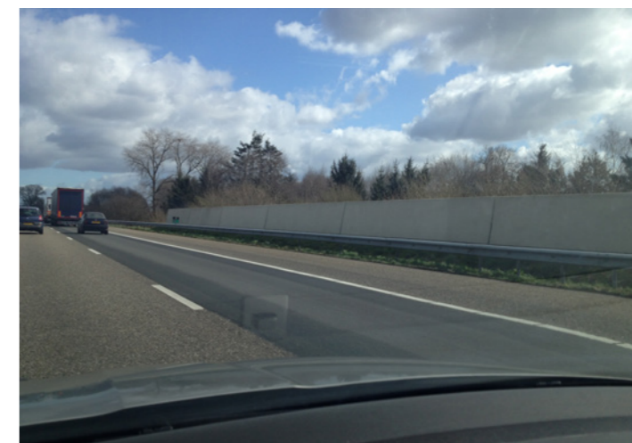
Rechterdeel foto: voorbeeld van toepassing van een laag muurtje als geluidwerende voorziening
