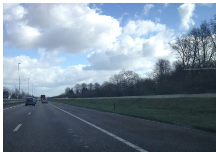
Rechterdeel foto: voorbeeld van toepassing van graswal met oplopend talud zonder geleiderail met laag muurtje als scherm (A59, ter hoogte van Nuland)
