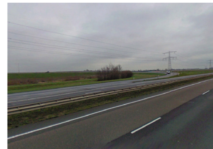
De A15 ter hoogte van de aansluiting bij Elst met alleen een geleiderail in de middenberm
