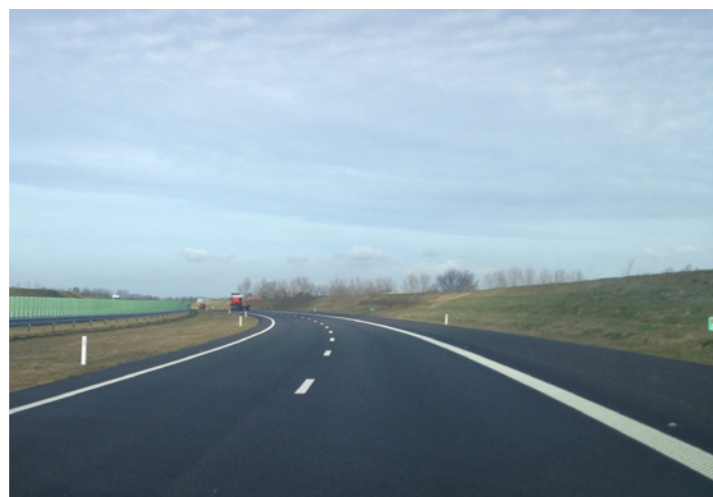
Rechterdeel foto: referentiebeeld van toepassing van een graswal met oplopend talud zonder geleiderail (A4-Zuid)
