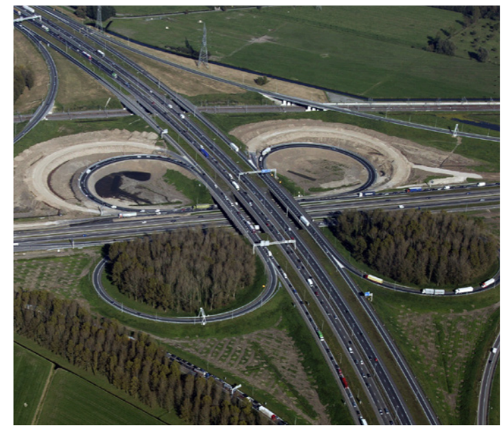
Knooppunt Valburg tijdens de recente reconstructie (bron: beeldbank Rijkswaterstaat)
