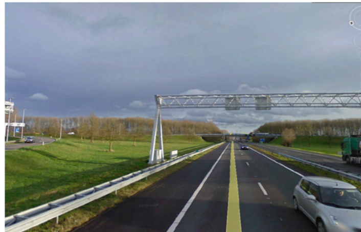
Zicht op knooppunt Oud-Dijk in de bestaande situatie (gezien vanuit het westen) als 'gesloten ensemble'
