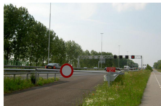
Voorbeeld van een calamiteitentoeegang
