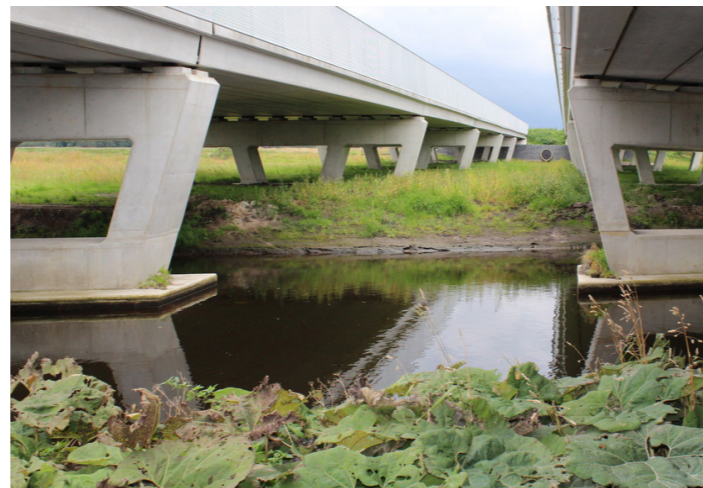
Referentiebeelden voor twee varianten van een open viaduct bij de Linge: open met hekjes (Centrale As) en met een rooster (A6 bij Almere). De voorkeur van de gemeente gaat uit naar de linkervariant.
