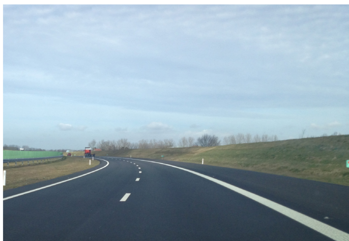
Aan de zuidzijde van de A15 komt een grondwal, met bloemrijk gras. Rechterdeel foto: referentiebeeld van toepassing van een graswal met oplopend talud zonder geleiderail (A4-Zuid).
