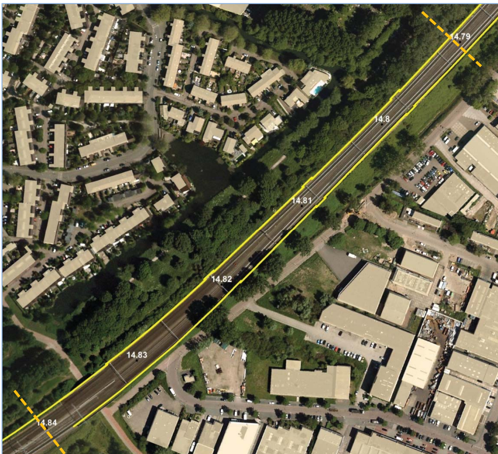
Afbeelding 11: Overzicht locatie schermen (gele lijn) die aanwezig ter hoogte van keersporen in Diemen, ter hoogte van de ophoging van het spoortalud
