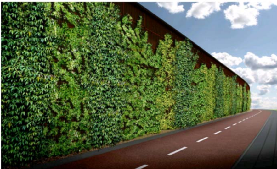
Figuur 7-7. Impressie van een afwerking grondkering en geluidsscherm met bioblocks en beplanting na 3 jaar. Bron: Analyse stedenbouwkundige inpassing, ZuidPlus 2018.
