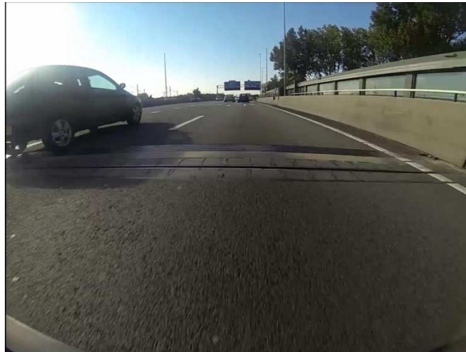
Figuur 6: Foto van de voeg (oostzijde).
