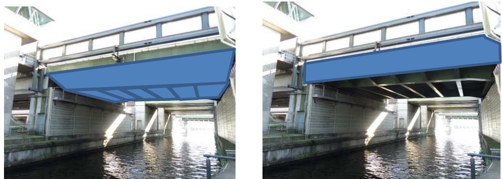
Figuur 43: Voorbeelden van kapseling (links) en afscherming (minder werking) van brugcomponenten (rechts), ter reductie van het middenfrequent geluid van de brugconstructie. De afscherming is mogelijk te integreren met het beweegbare geluidscherm.
