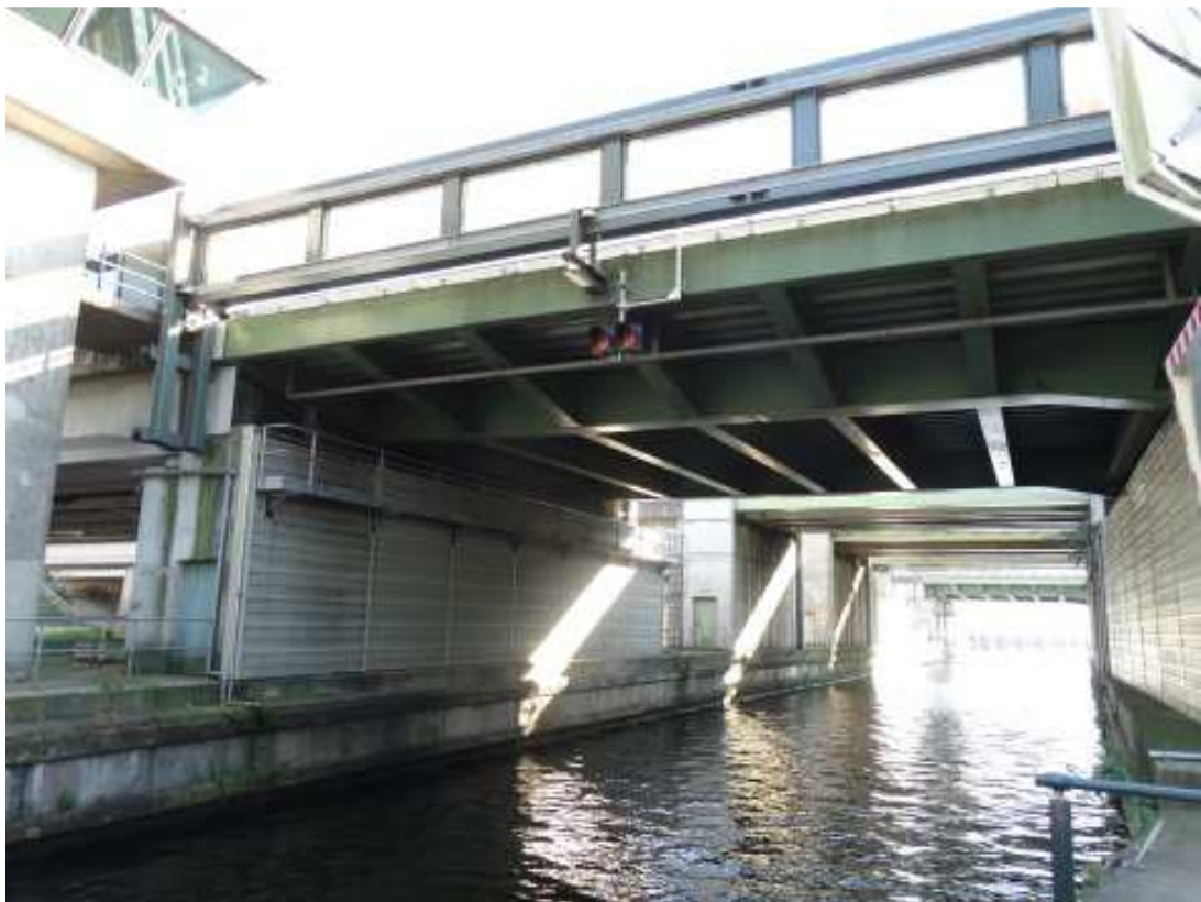
Figuur 2: Foto van de noordelijke Schinkelbrug. Aan weerszijden van de tunnel zijn absorptiecassettes aangebracht. De basculekelder met draaipunt is rechts.
