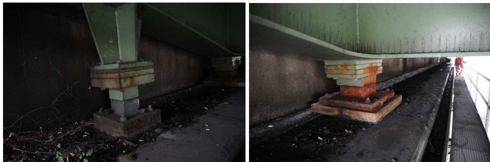
Figuur 4: Foto's van de oplegpunten van de val (oostzijde), links de hulpoplegging, rechts de hoofdoplegging onder de hoofdligger.
